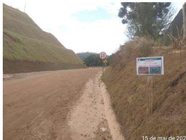
Foto 32 – Percurso percorrido na ADA do empreendimento. (Data: 15/05/2021).
