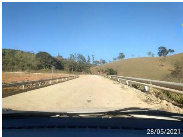
Foto 33 – Percurso percorrido na ADA do empreendimento. (Data: 28/05/2021).
