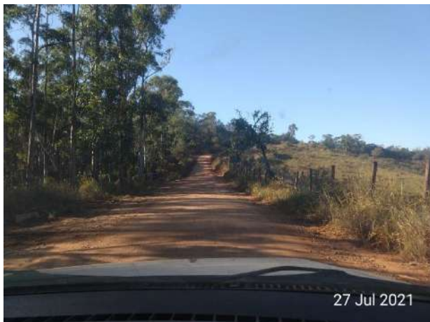
Foto 41 – Percurso percorrido na ADA do empreendimento. (Data: 27/07/2021).
