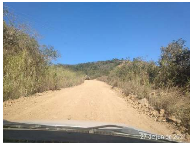
Foto 38 – Percurso percorrido na ADA do empreendimento. (Data: 27/06/2021).
